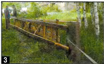
3 Подготовка к транспортировке — к передним концам балок снизу подшит лист железа.
