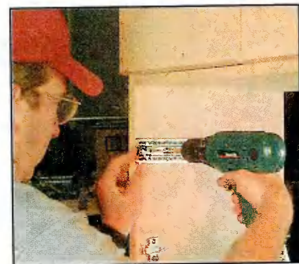
От этой отметки по угольнику проводят линии и, отступив 5 мм от передней плоскости шкафчика, устанавливают направляющие.
