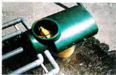
4 Бактериологический фильтр обеспечивает окончательную очистку и слив воды во внешнюю гидравлическую среду.
