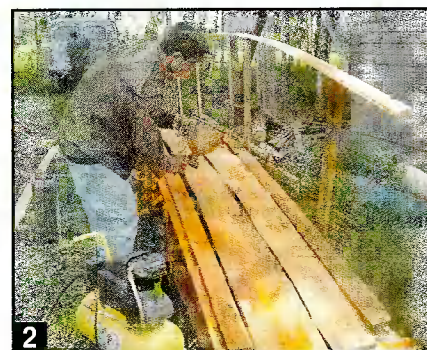
Перед сдачей моста в эксплуатацию, все элементы конструкции были тщательно обработаны антисептиком.
